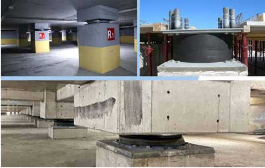
Şekil – 2: Sismik İzolatörlerin Görünümleri
